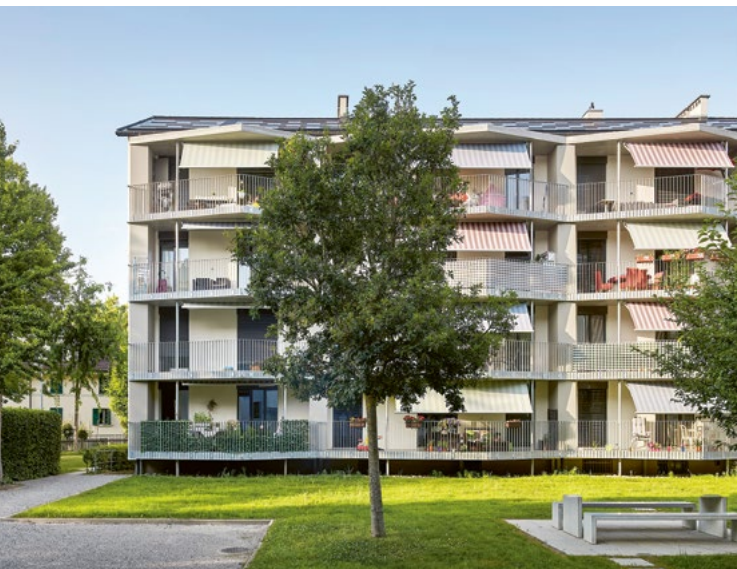
Die Liegenschaften an der Kleefeldstrasse wurden totalsaniert.
